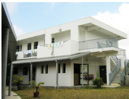
Bâtiment existant renové
